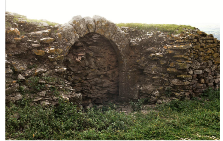
"Porta da Traição" previous to project. 2016 © PP
